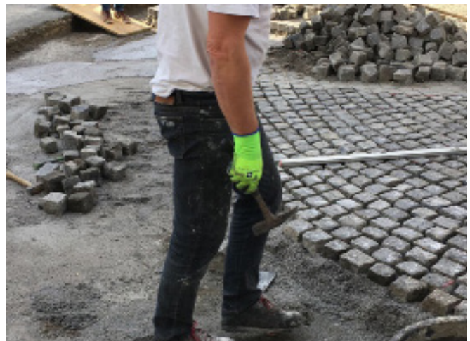
Schnellstaushärtende Instandsetzungen und Sanierungen
